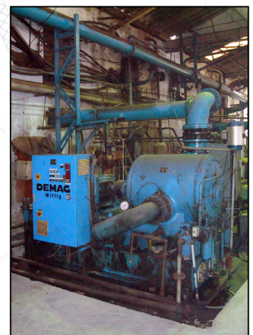
Bombas Wittig WPSO substituidas
